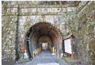
旧東海道線逢坂山隧道跡
