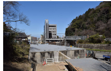
逢坂山隧道跡から大津方面を見る
